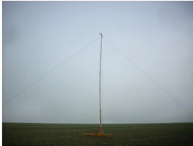
Photo du mât météo positionné à proximité du PF2
